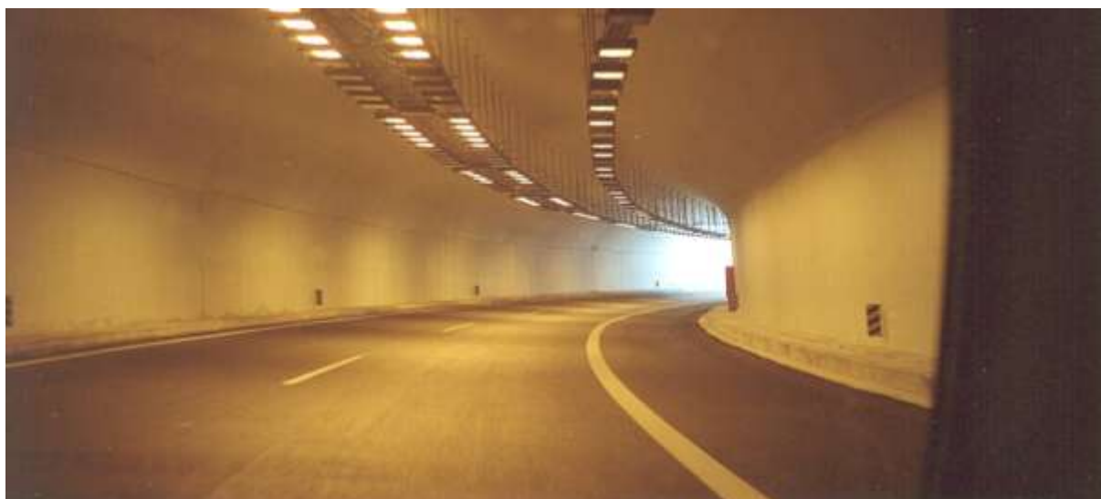
Cut & Cover στη Χ.Θ. 9+590 - 9+820 του τμήματος Παράκαμψης Καβάλας της Εγνατίας Οδού
