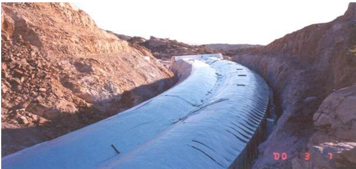
Σήραγγα Cut & Cover σε φάση κατασκευής
